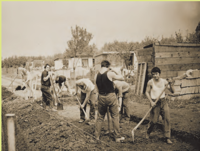
Die Anlage von Hauptwegen im Kleingartenverein "Sparte 73 e.V." in Baalsdorf (1973)
