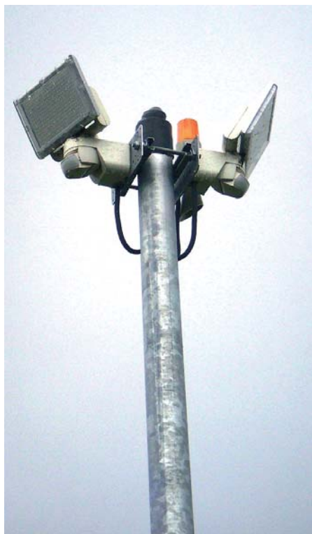
Bringt Licht ins Dunkel und stört ungebettene Besucher: Beleuchtungsanlage mit Bewegungsmelder auf dem Hauptweg einer Anlage. Foto: SLK
