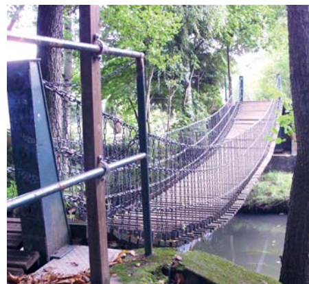
Der Zugang über die Hängebrücke am Rosental. Foto: SLK
